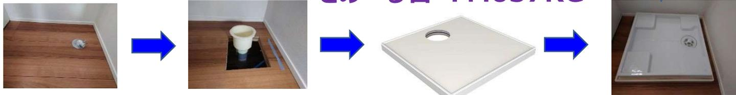
床下空間が有れば、既存トラップを取り外し配管調整 + とめーる君 + 640パン取付で終了！
